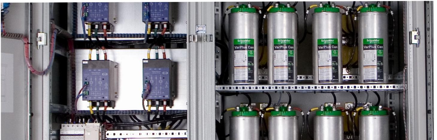
**Коэффициент мощности ( $\cos \varphi$ )** - это отношение активной мощности ( $P$ ) к полной мощности ( $S$ ), потребляемой электрическим приемником из сети.
